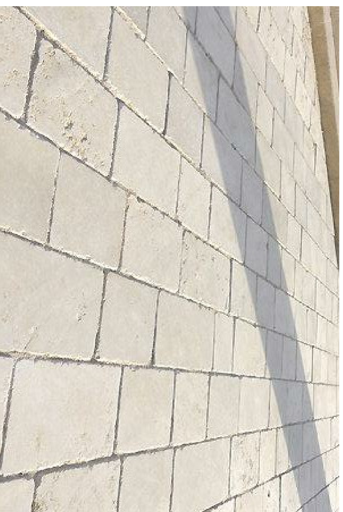
SOSTITUZIONE DI PAVIMENTAZIONE MARCIAPIEDE IN PIETRA DI TRANI
